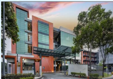
Vantage Data Center
